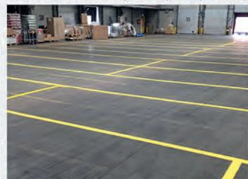
Kalt-Plastik-Masse aufgelegt Markierungsarbeiten bei DHL
